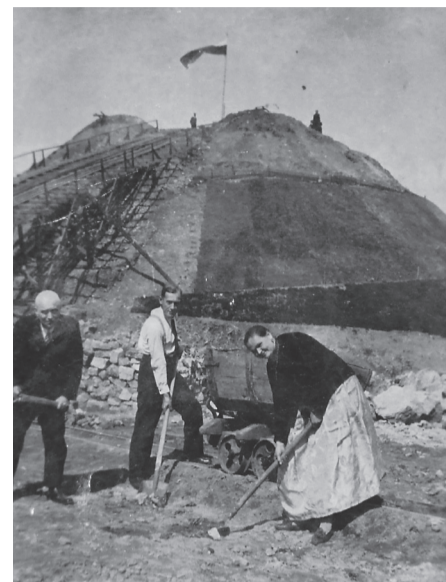
13.09.1936 r. Budowa kopca. Zdjęcie ze zbiorów prywatnych rodziny Wroźyna
