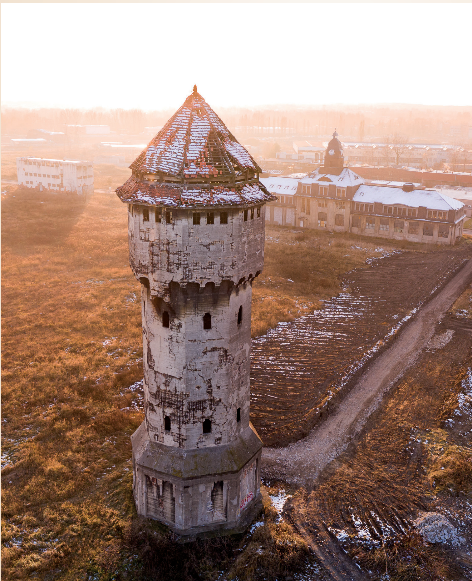
Wieża cisnień oraz budynek dyrekcji dawnej huty Uthemanna. Fot. Adam Rostecki
