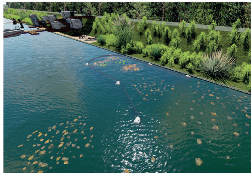
Widok na siatkę na zanieczyszczenia kanału
