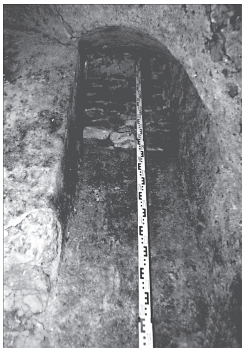
Ryc. 5. Udórz, dwór. Pomieszczenie piwniczne 02a. Zamurowane okno we wschodniej partii ściany północnej. Widok od południa. Stan z 2001 roku
