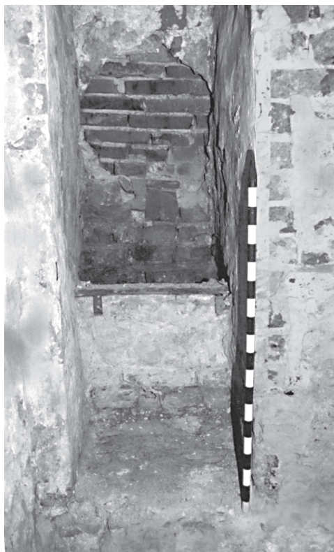
Ryc. 4. Kamieniec, „Mysia Wieża”. Odkryta podczas prac latryna
