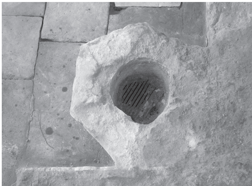
Ryc. 3. Oświęcim, Wielka Synagoga. Konstrukcja ceglana z kratką ściekową
