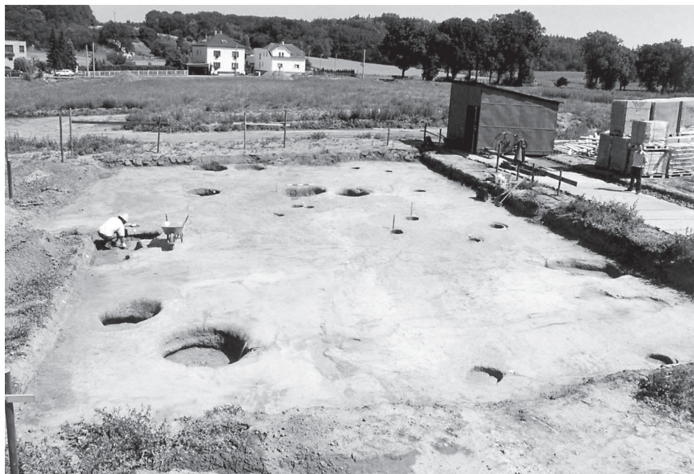
Obr. 2. Koberice. Pohled na plochu staveniště jednoho z rodinných domů se zahloubenými sídlištními objekty lučické kultury
