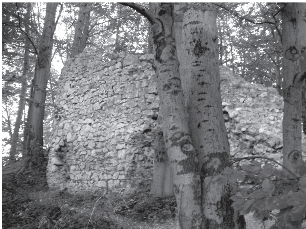
Ryc. 3. Udórz. Relikt zachodniej partii muru obwodowego zamku. Widok od południowego zachodu
