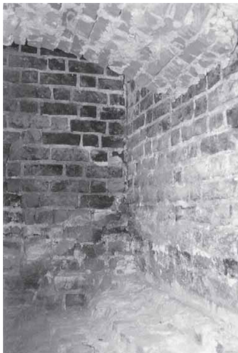
Ryc. 4. Wieża bramna, pomieszczenie 2. Widok na lico ściany muru kurtynowego (z prawej) oraz na dostawioną do niego ścianę zewnętrzną, wschodnią ścianę wieży bramnej
