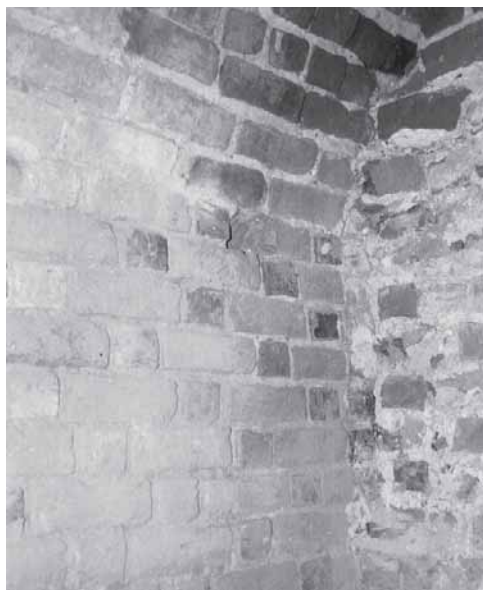
Ryc. 6. Wieża bramna, pomieszczenie 3. Widok na lico ściany muru kurtynowego (po lewej) oraz na dostawioną do niego ścianę zewnętrzną, zachodnią ścianę wieży bramnej
