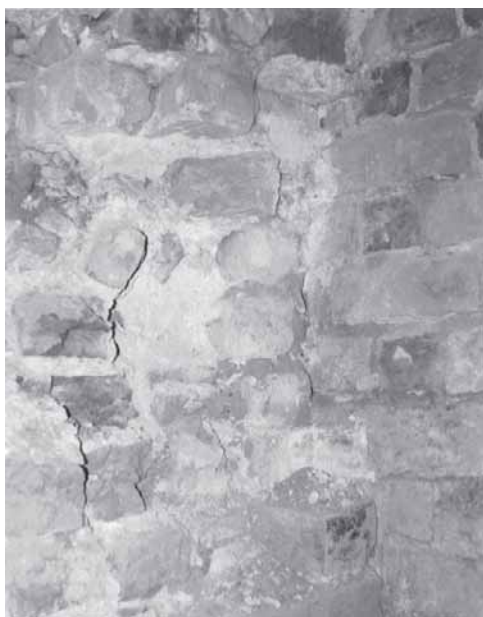
Ryc. 5. Wieża bramna, pomieszczenie 3. Widok na lico muru kurtynowego (po prawej) oraz dostawioną do niego ścianę wschodnią pomieszczenia 3
