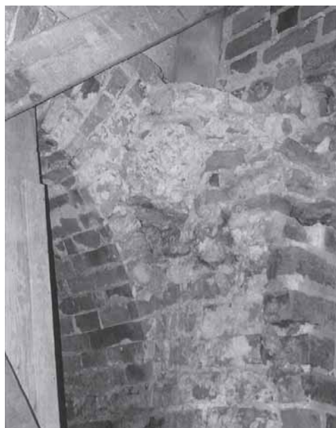
Ryc. 7. Wieża bramna. Widok na zachodnią, kamienną panewkę osi obrotowej mostu zwodzonego
