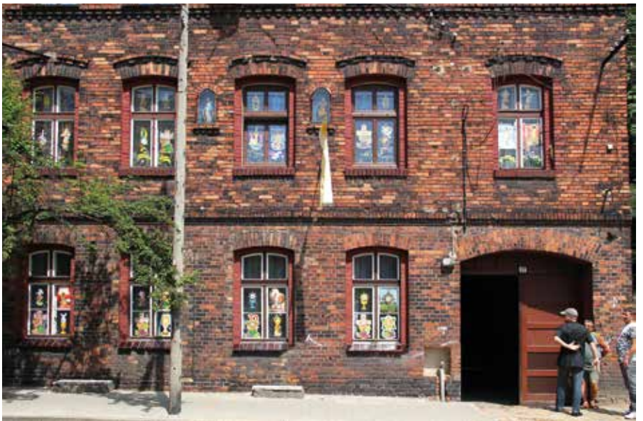
← Przystrojone okna (Decorated windows). Bytom-Rozbark. 2018 r.
