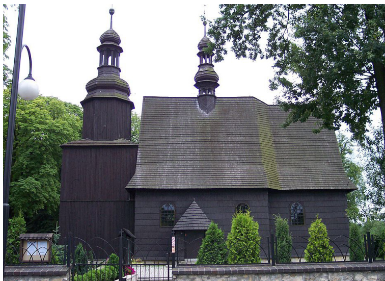
kościół Wniebowzięcia NMP w Gliwicach (1493?)
