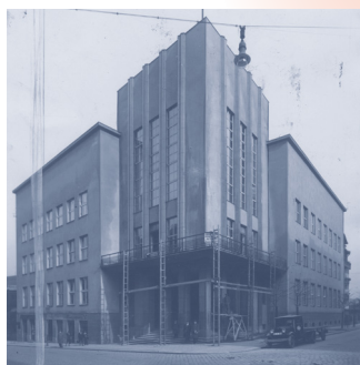
Budowa Domu Oświatowego Towarzystwa Czytelni Ludowych w Katowicach, źródło: NAC
