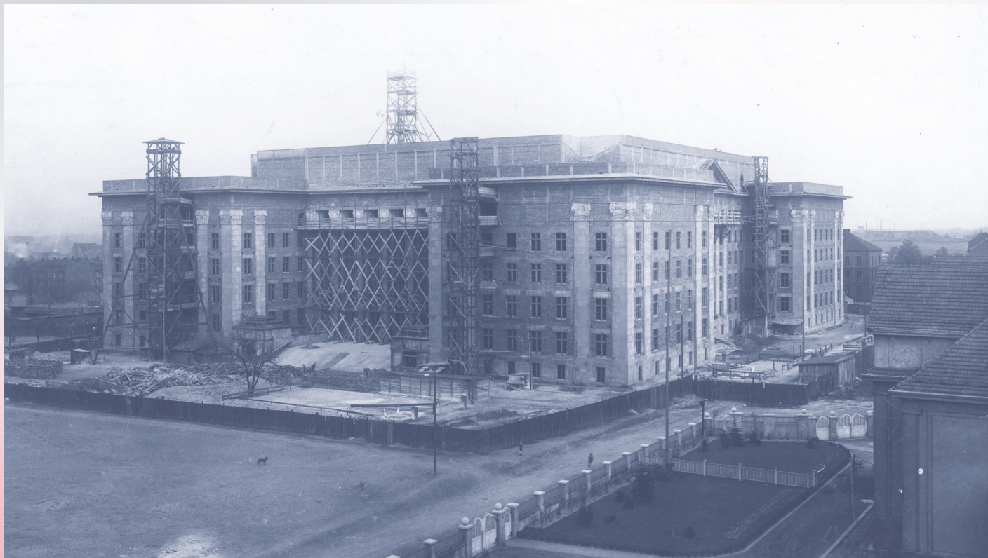
Budowa gmachu Sejmu Śląskiego i Urzędu Wojewódzkiego w Katowicach, źródło: NAC
