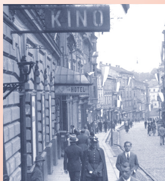
Cieszyn. Ulica Głęboka, źródło: NAC
