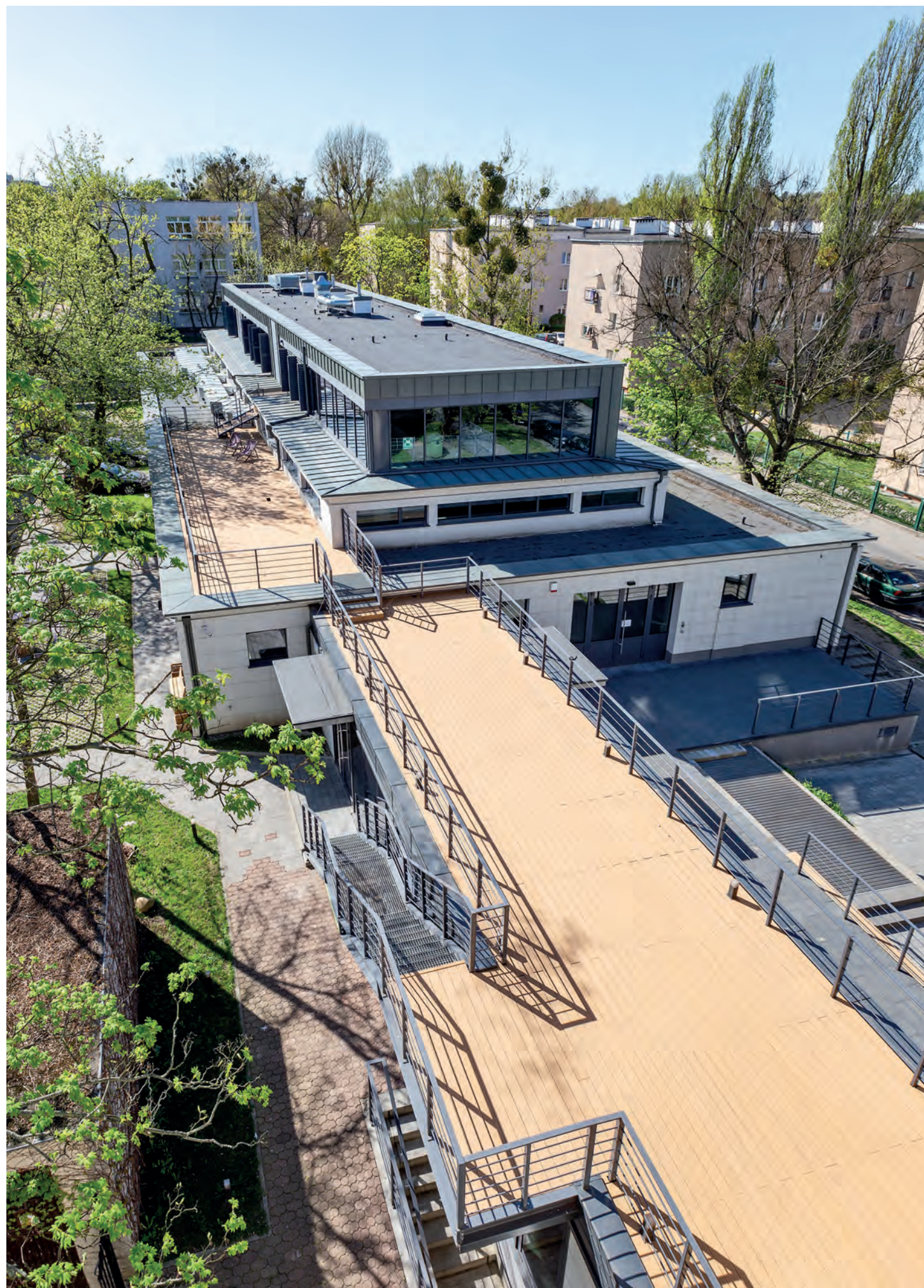
Hala Ożarowska na osiedlu Koło w Warszawie, fot. Marcin Czechowicz
