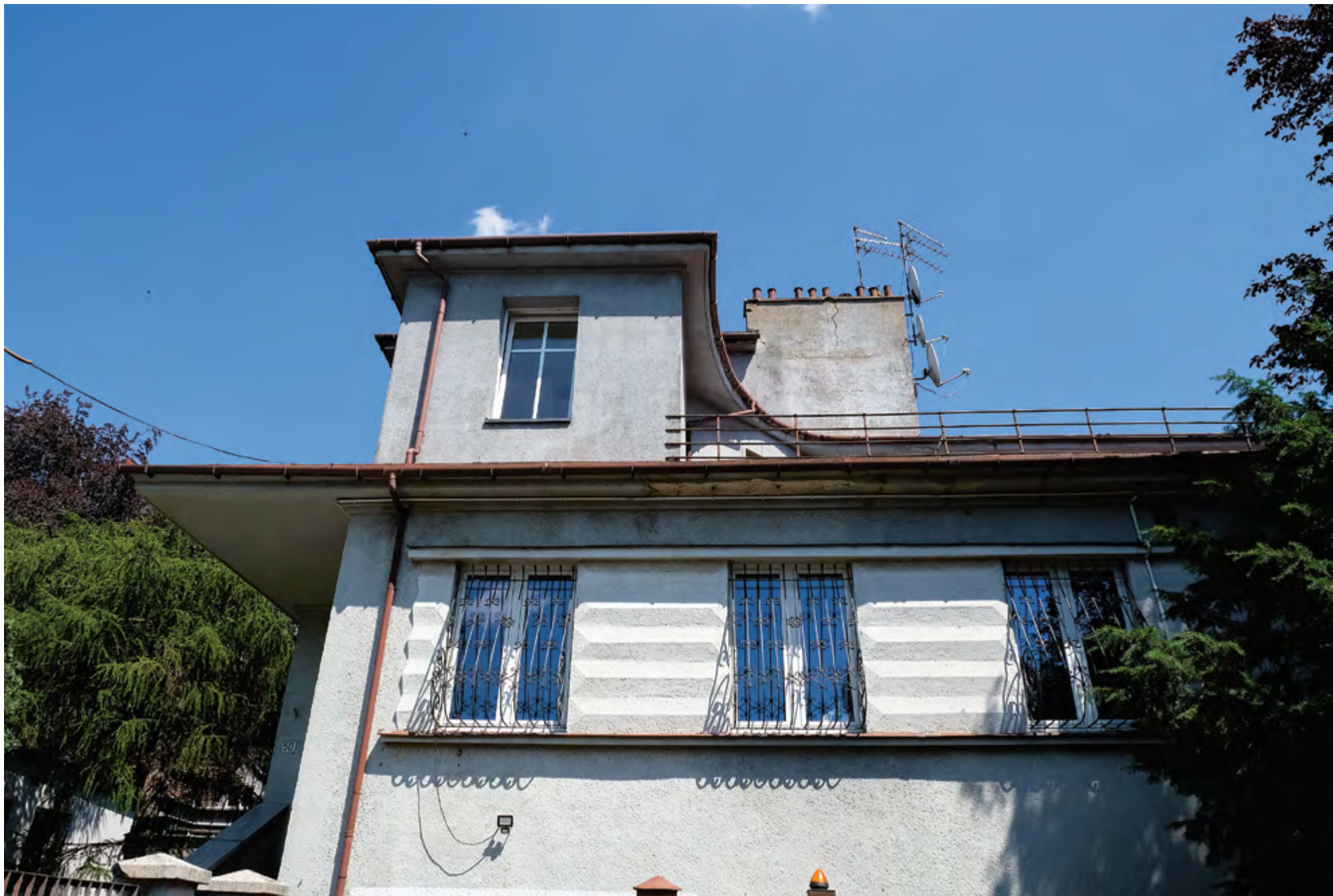
Katowice, willa Władysława Michejdy przy ul. Kilińskiego 50, fragment elewacji, fot. A. Gola, 2025
