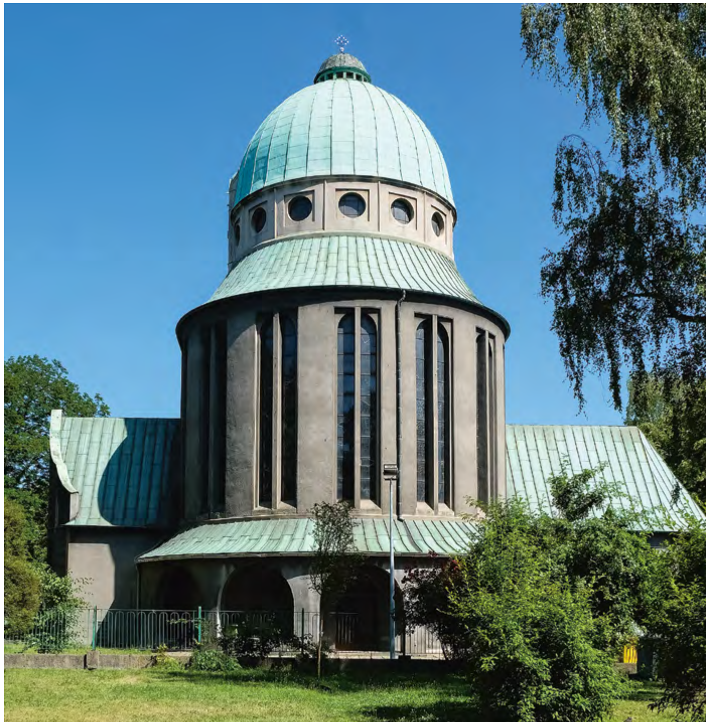
Bytom, kościół pw. św. Barbary przy ul. Chełmońskiego 18, widok na chór, fot. A. Gola, 2025
