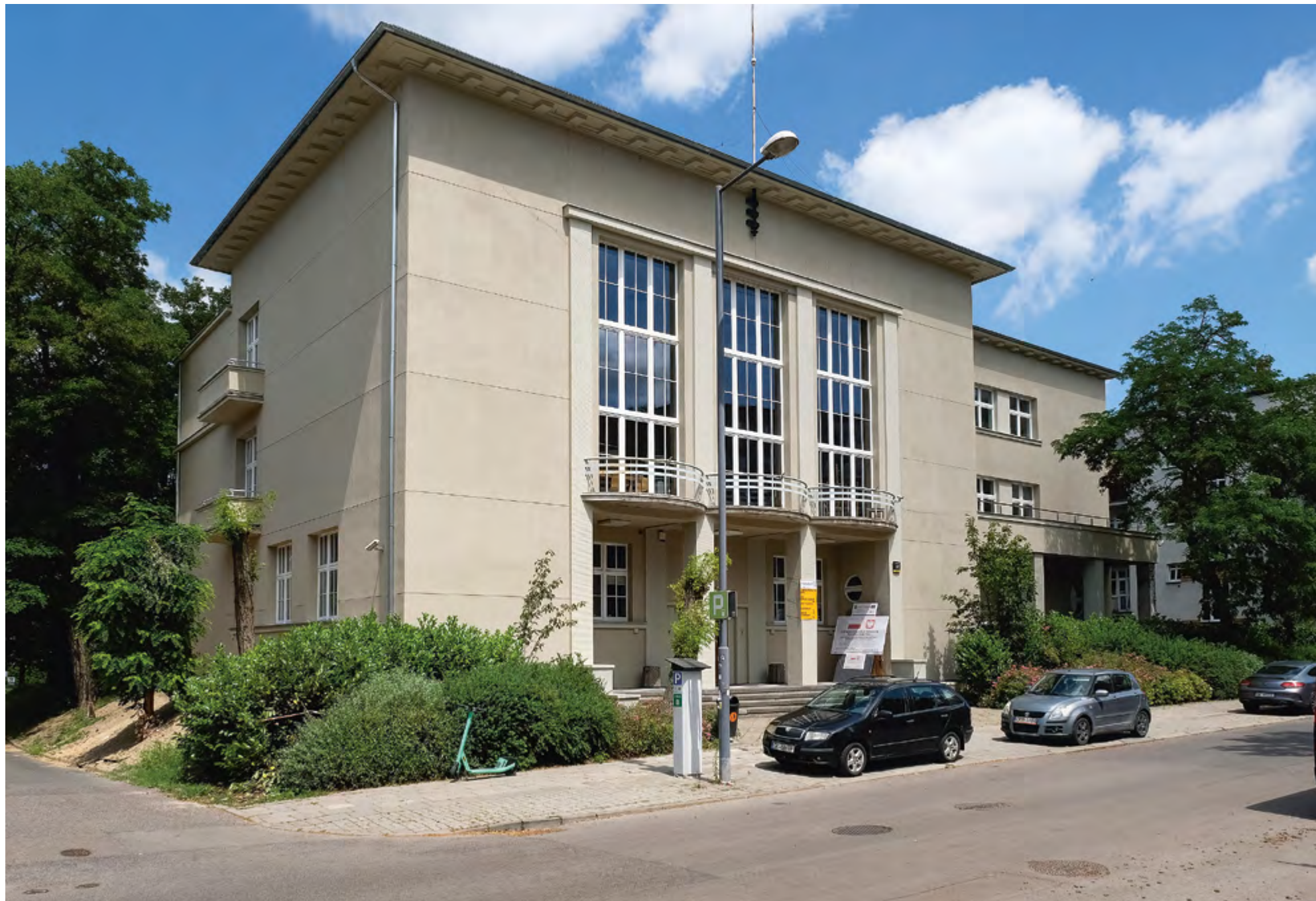
Katowice, dawne kasyno oficerskie przy ul. Raciborskiej 37, fasada wejściowa, fot. A. Gola 2025
