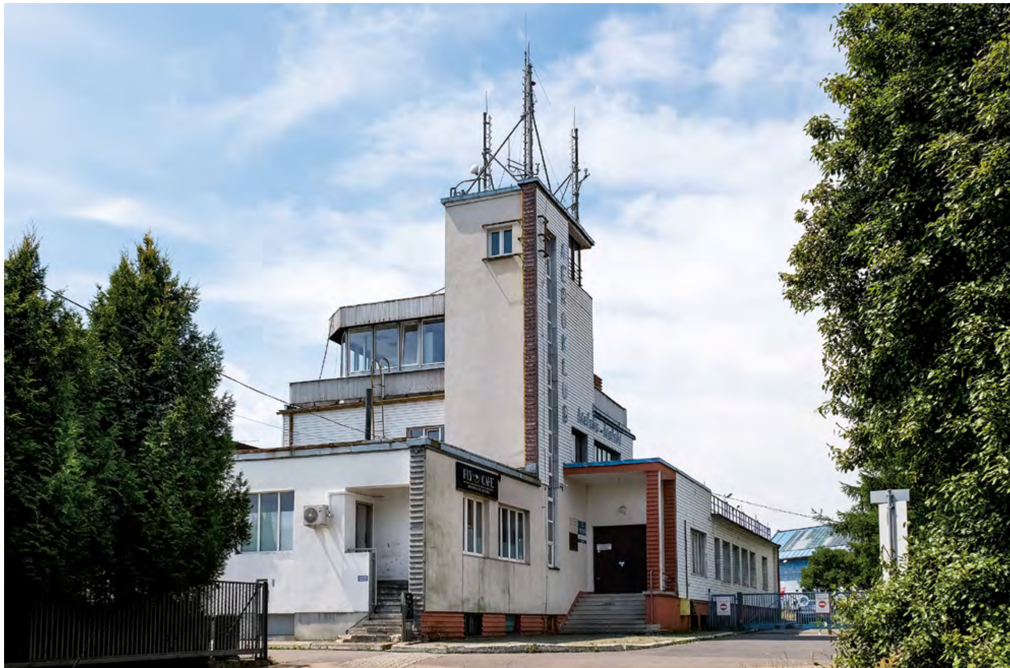
Bielsko-Biała, lotnisko sportowe w Aleksandrowicach przy ul. Cieszyńskiej 321, elewacja boczna, fot. A. Gola, 2025
