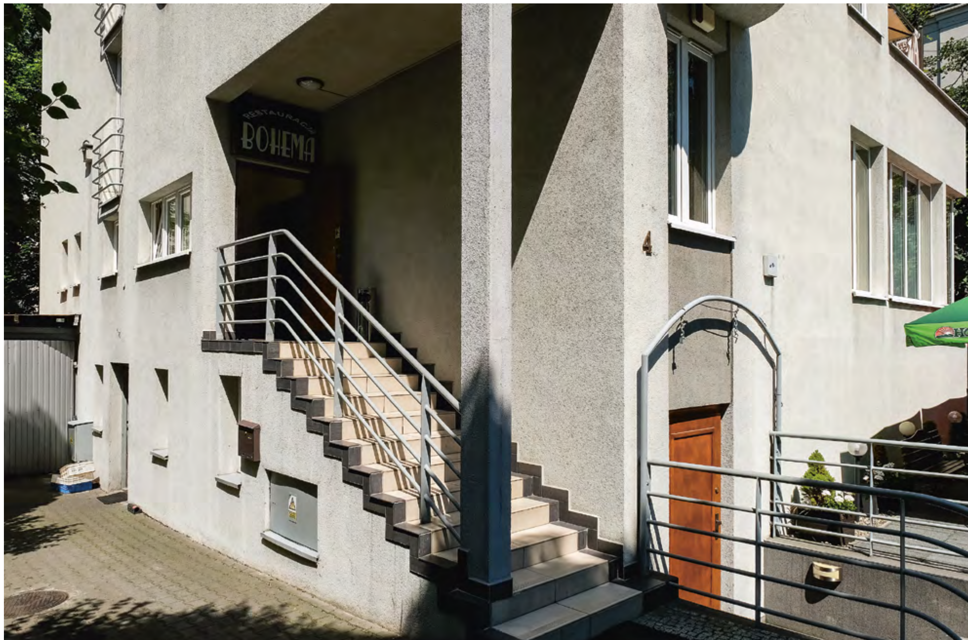
Katowice, willa mecenasa Edmunda Kaźmierczaka przy ul. Bratków 4, wejście, fot. A. Gola, 2025
