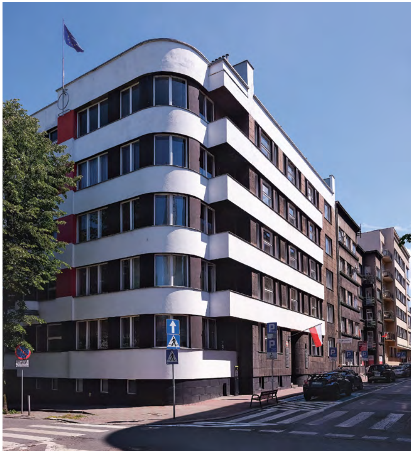
Katowice, dom Wędkowskich przy ul. PCK 10, fot. A. Gola, 2025
