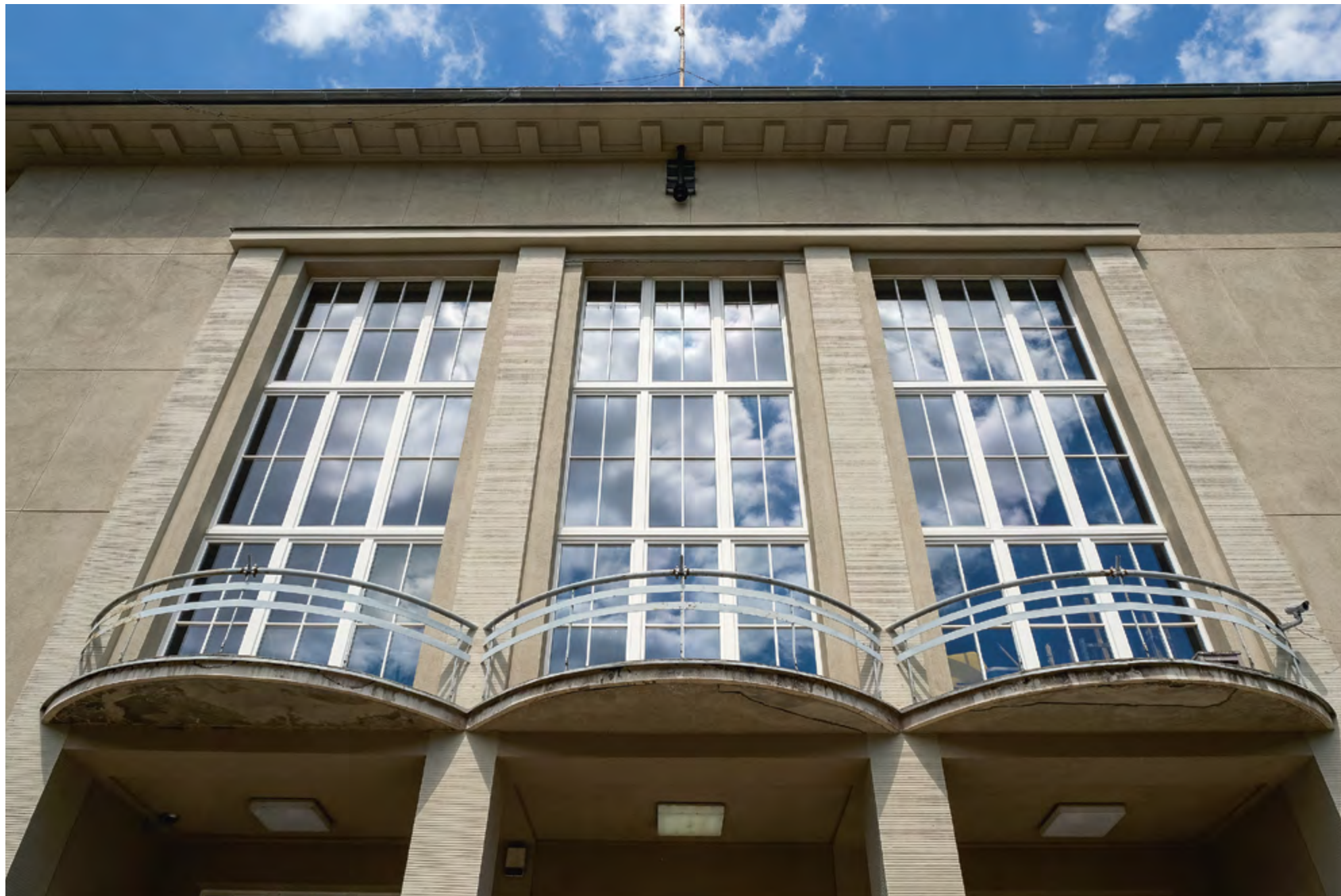
Katowice, dawne kasyno oficerskie przy ul. Raciborskiej 37, okna z balkonami nad portykiem wgłębnyim głównego wejścia, fot. A. Gola, 2025
