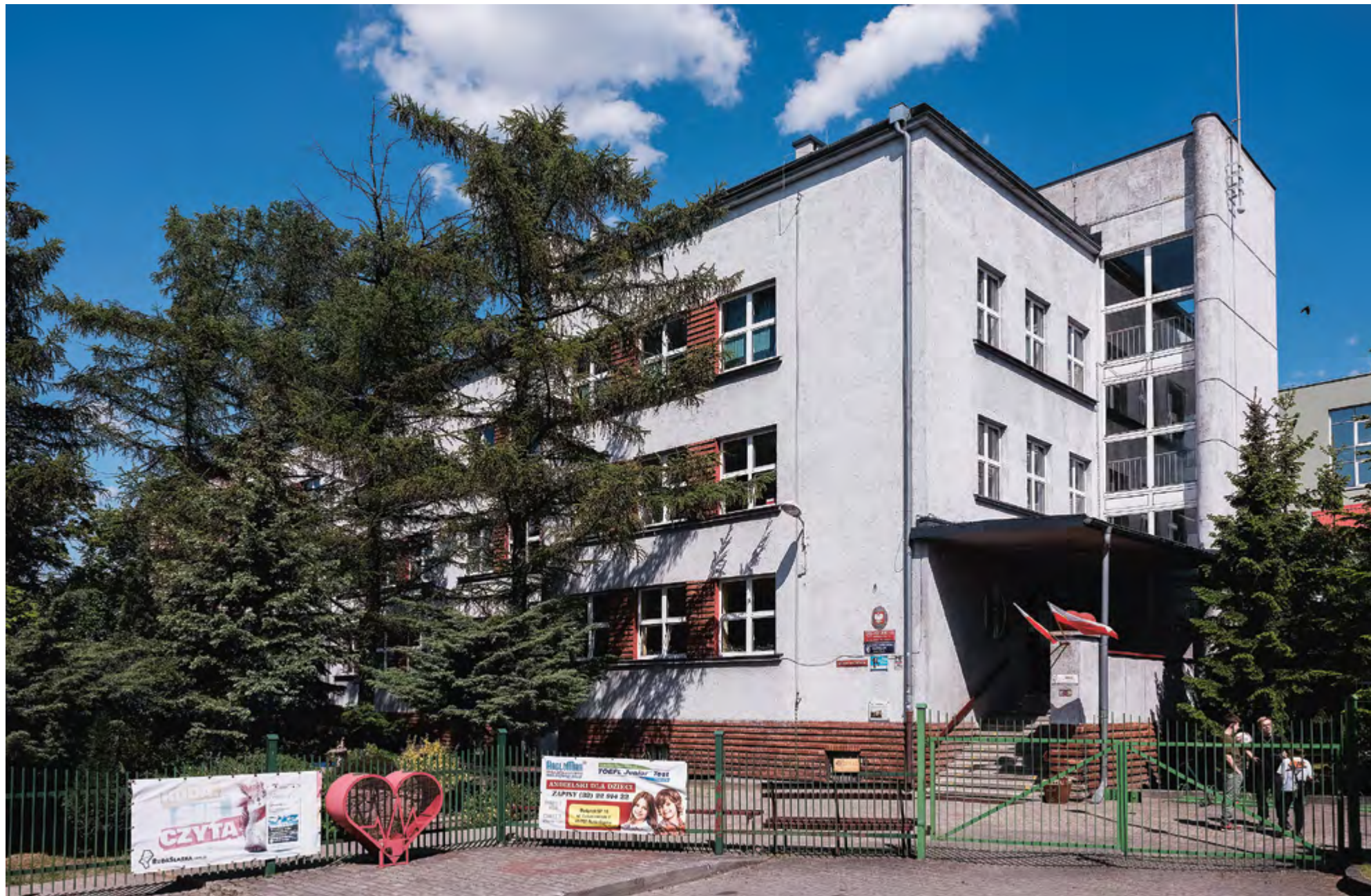
Ruda Śląska-Kochłowice, szkoła przy ul. Łukasiewicza 7, fragment elewacji z wejściem, fot. A. Gola, 2025
