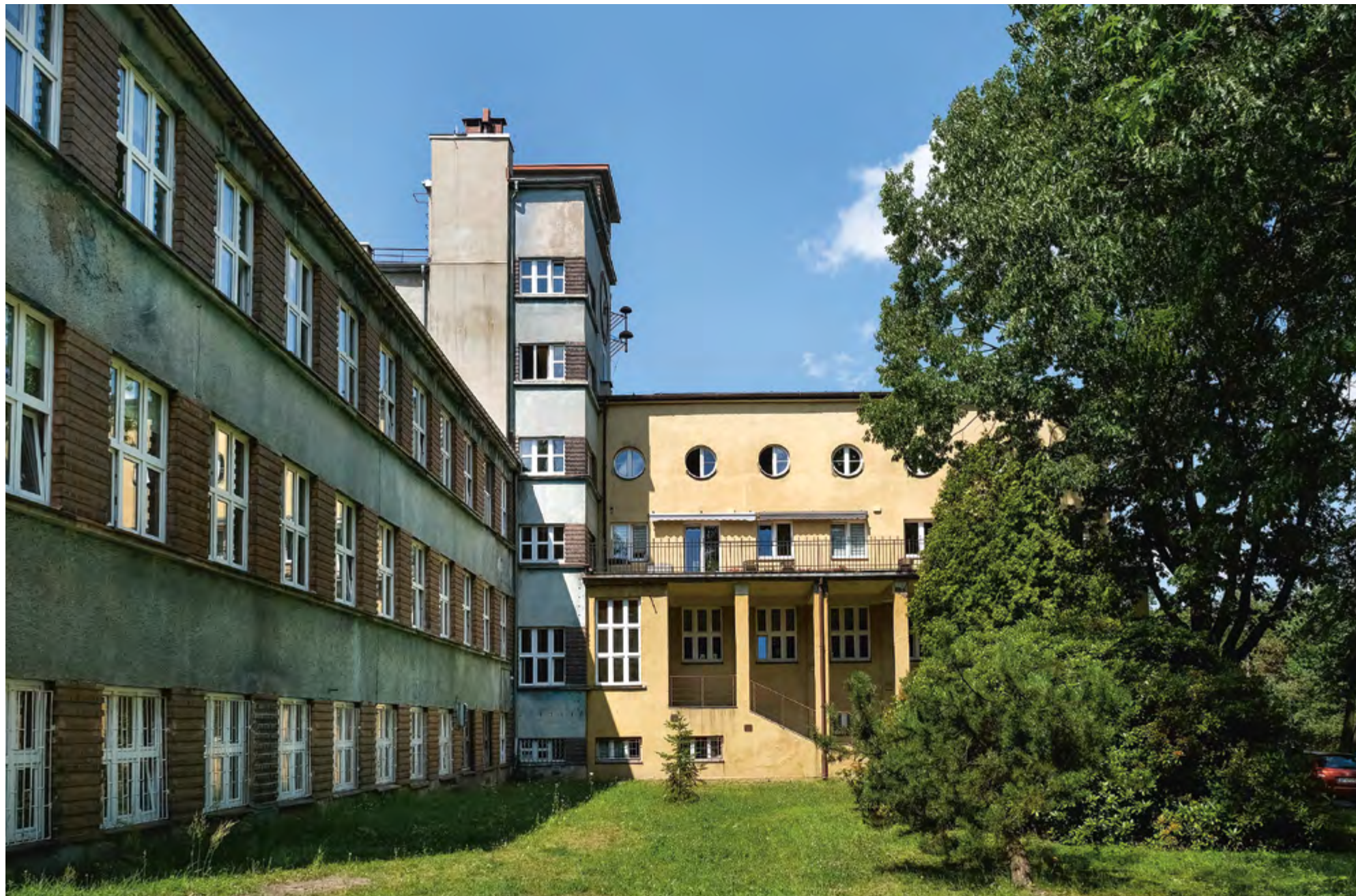
Katowice, dawny ratusz gminy Janów przy ul. Szopienickiej 59, widok od południa, fot. A. Gola, 2025
